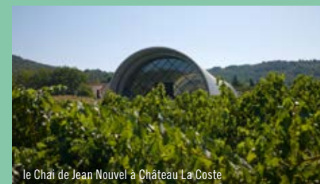
Le Chai de Jean Nouvel à Château La Coste
